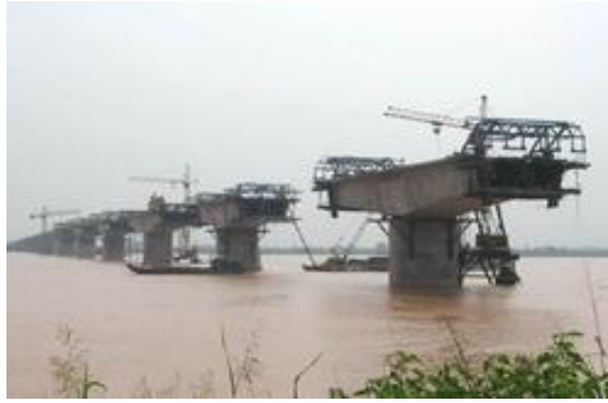
Hình 1.9 Cầu Vĩnh Tuy với kết cấu dầm hộp bê tông dự ứng lực
