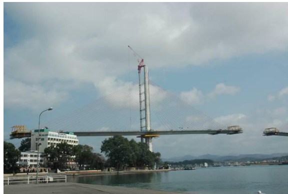
Hình 1.10 Cầu Bãi cháy – Cầu dây văng có dầm bằng bê tông dự ứng lực
