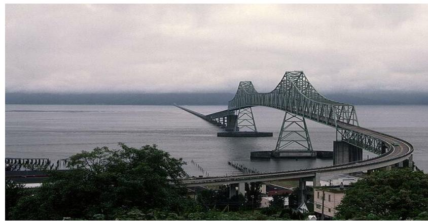
Hình 1.10b – Cầu có đường xe chạy dưới
