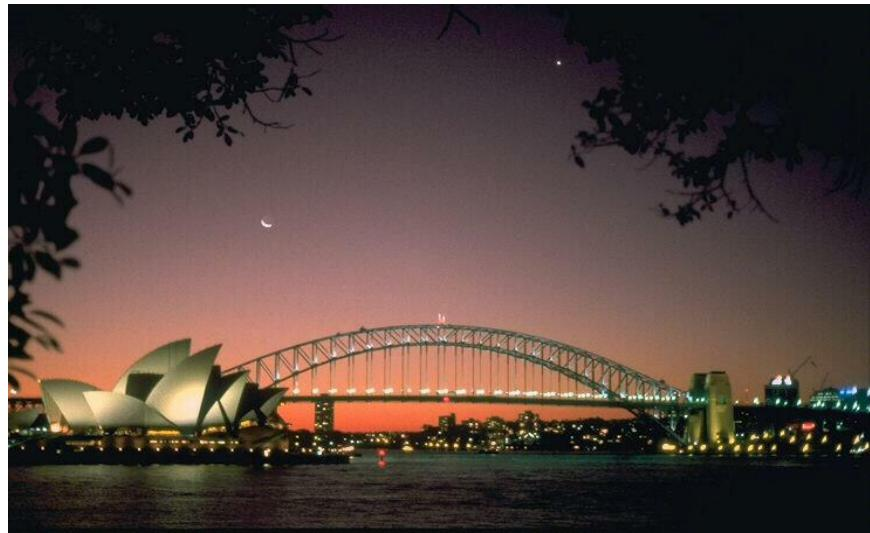
Hình 1.10c – Cầu có đường xe chạy giữa
