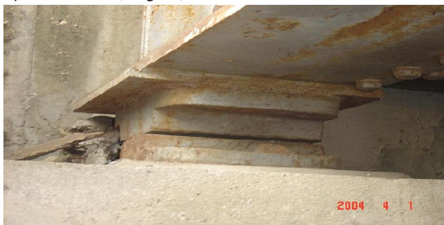
Hình 2.34 – Gối tiếp tuyến được dùng trong thực tế
