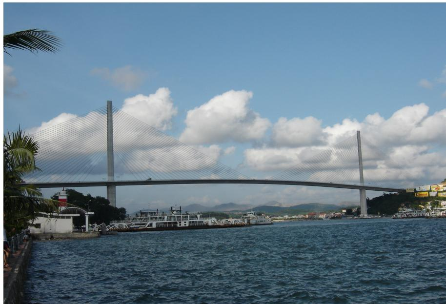
Hình 1.18b – Cầu Bãi Cháy – Cầu dây văng một mặt phẳng dây
