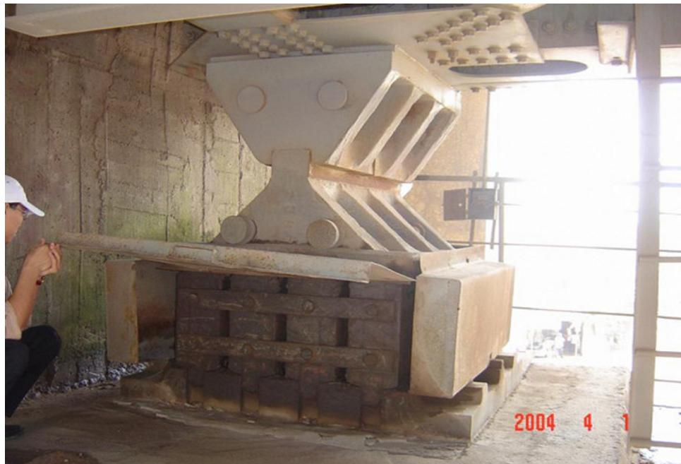
Hình 2.36 – Gối có nhiều con lăn được sử dụng ở cầu Thăng Long
