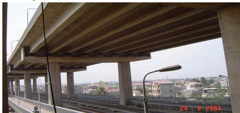
*Hình 1.11d – Cầu có kết cấu nhịp bằng bê tông cốt thép*
