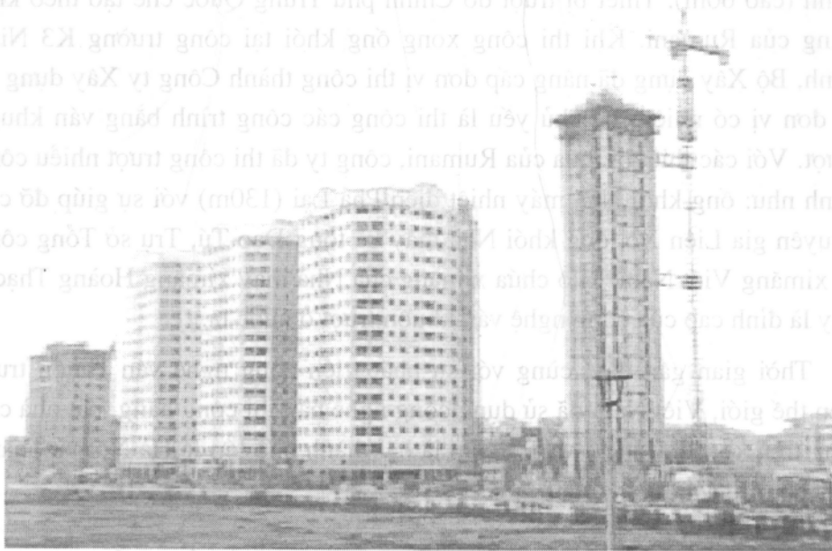
Hình 1. Thi công trượt lõi công trình dân dụng
