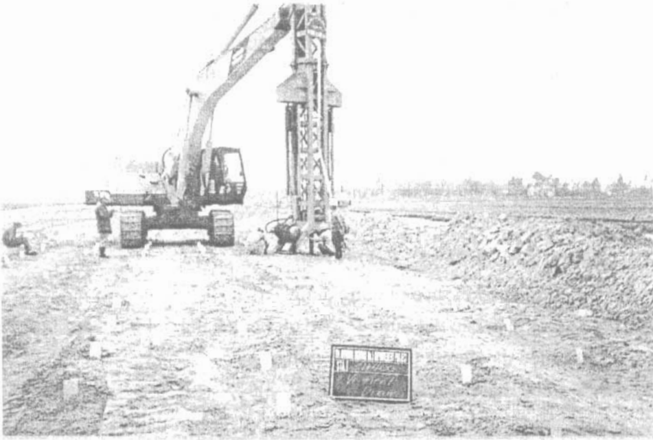
Hình 5.30. Thiết bị tiêu biểu để gia cường đất yếu bằng bắc them (PVD).
