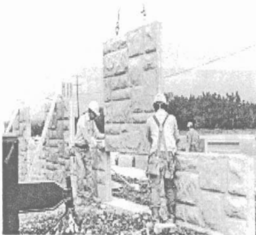
Hình 7.5. Lắp đặt các tấm đúc sẵn bảo vệ bề mặt.
