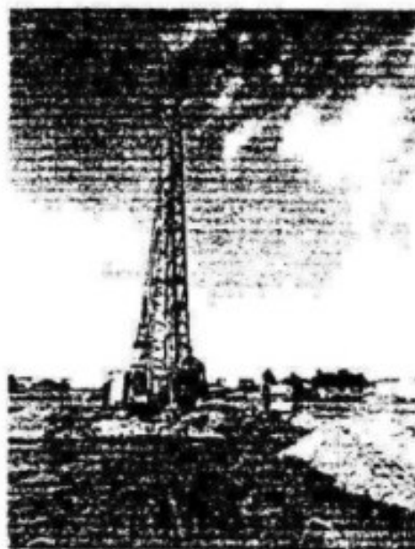
Hình 1.1. Thiết bị thi công cọc cát.
