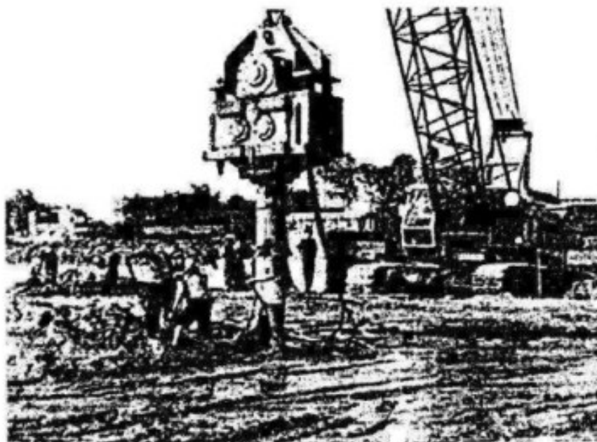
Hình 1.2. Đưa cát vào ống cọc.
