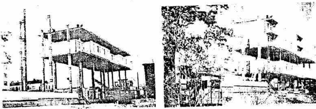
Hình 3-50. Xây dựng nhà theo phương pháp nâng tầng ở Liên Xô
