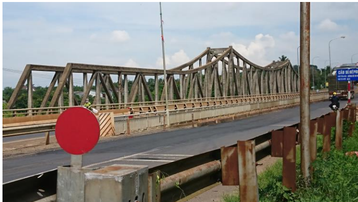
Hình 1.3: Cầu giàn Serepok Quốc lộ 14- Đắc Lắc
