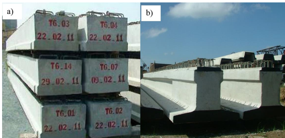
Hình 1.12: Kết cấu nhịp giản đơn tiết diện bản lắp ghép và T-ngược
