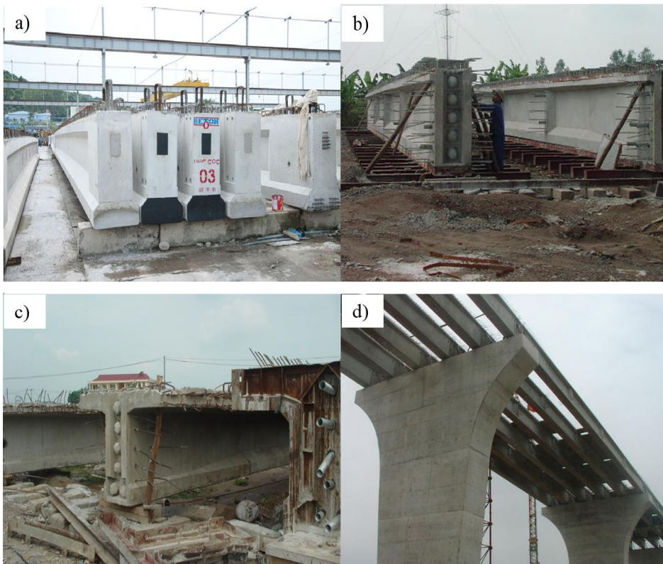
Hình 1.11: Kết cấu nhịp giản đơn tiết diện chữ I, T
