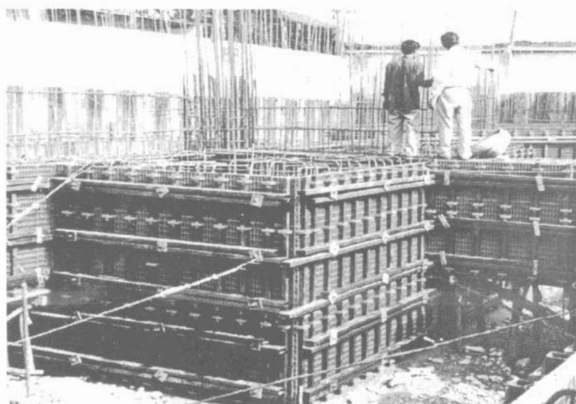
Hình 1.155. Ván khuôn khối lớn bằng tấm FUVI
