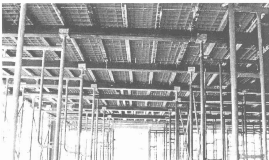
Hình 2.01. Bộ giàn giáo công cụ chống đỡ ván khuôn sàn
