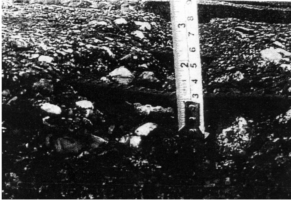
Hình 2.1. Bê tông mũi phun tràn Kẽ Gõ bị phá hoại
