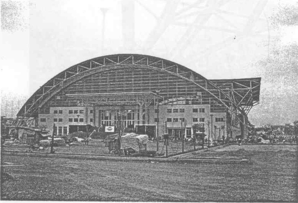
Hình 3.7: Nhà thi đấu Phú Thọ - TP. HCM - vòm thép nhịp 121m
