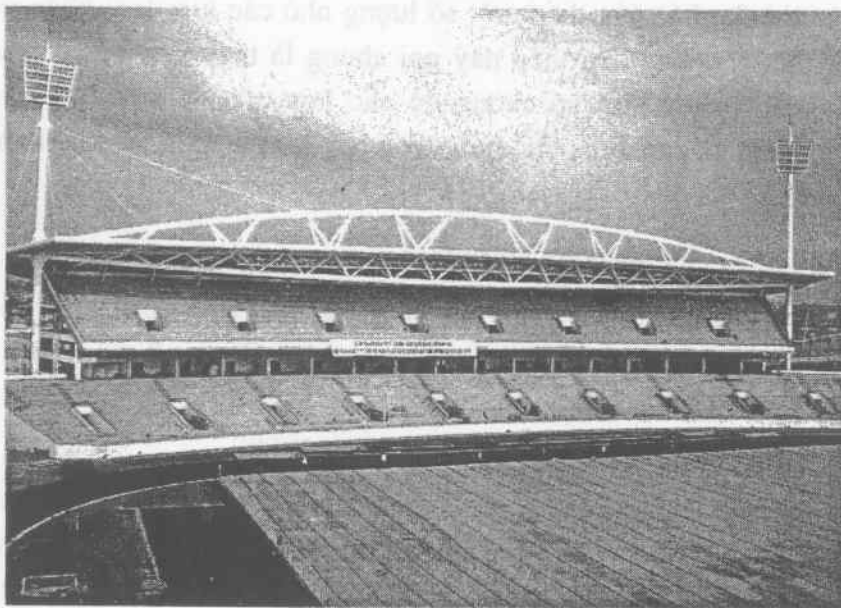
Hình 3.27: Sân vận động quốc gia Mỹ Đình - kết cấu thép ống nhịp 153m
