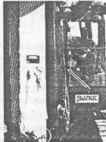
3 - Lắp các thiết bị đo vào đầu cọc 4 - Đóng búa
