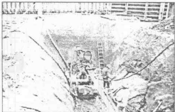
Hình 2.16: Bơm chỗ khe nứt a) Sơ đồ; b) Hiện trường
