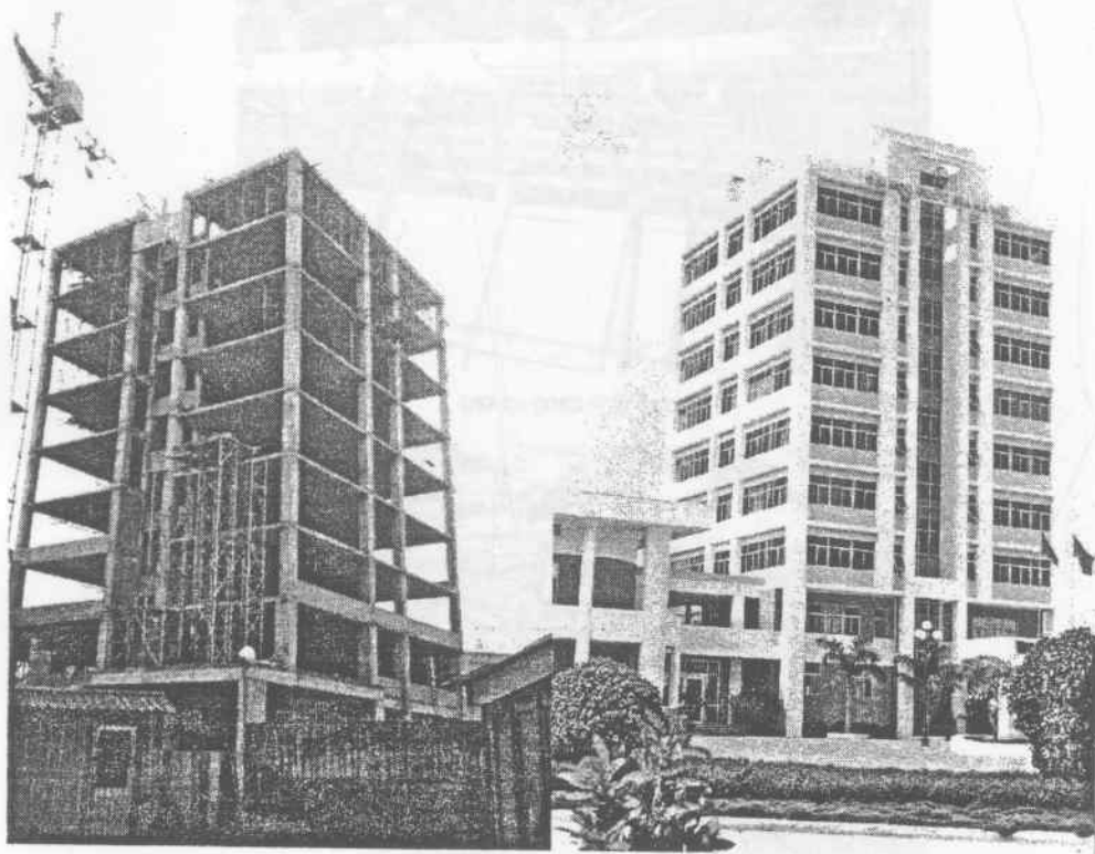
Hình 4.19: Sàn phẳng không dầm BTULT dùng cho lưới cột 7,8m \times 7,8m công trình Nhà điều hành - Đại học Quốc gia Hà Nội (Công trình đầu tiên dùng sàn bê tông ULT không dầm do Việt Nam thiết kế và thi công năm 1995).
