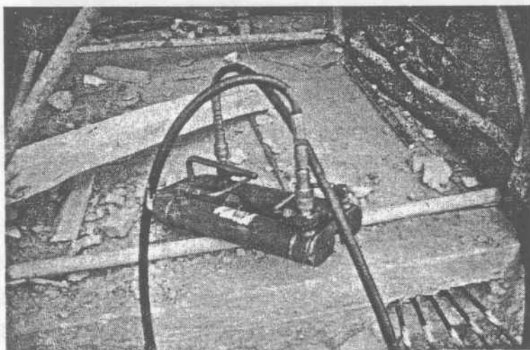
Hình 4.18: Kịch hai thì dùng để căng cáp trên bê tông
