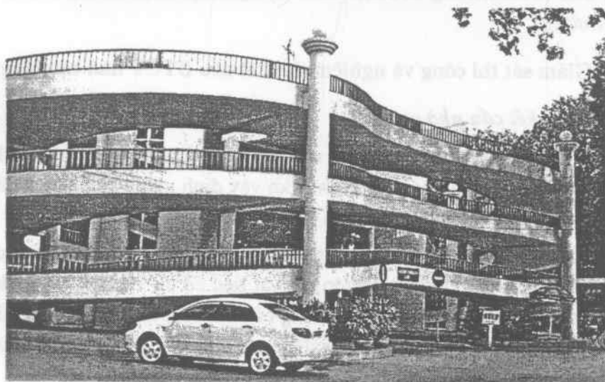
Hình 4.23: Sàn để xe Bệnh viện Bạch Mai Hà Nội dùng bê tông ULT lưới cột 10,2 \times 6\text{m} dùng dầm bản rộng và cáp không bám dính.
