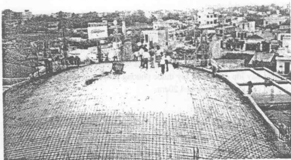
Hình 4.11: Thi công mái vòm
