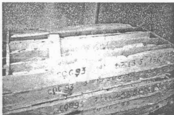
Hình 4.28: Lấy mẫu bê tông cọc
