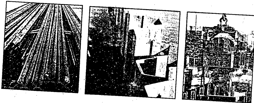
Hình 4.17: Các dạng cọc thép và búa rung
