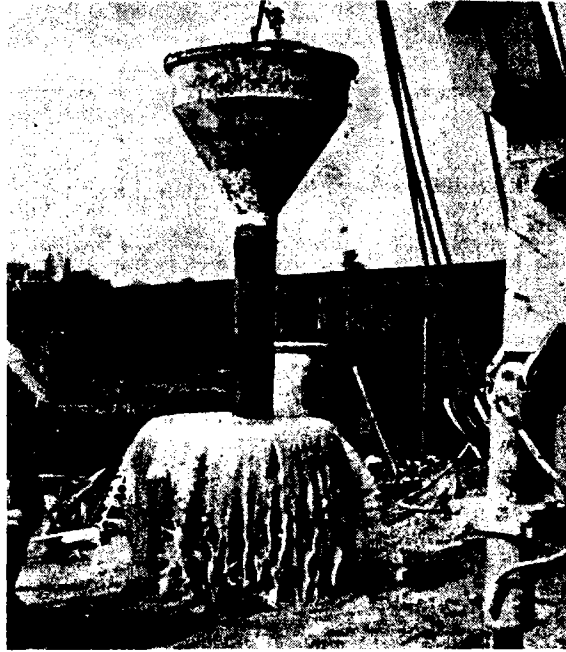
Hình VIII - 26: Vừa đổ bê tông vừa rút ống dẫn lên từ từ
