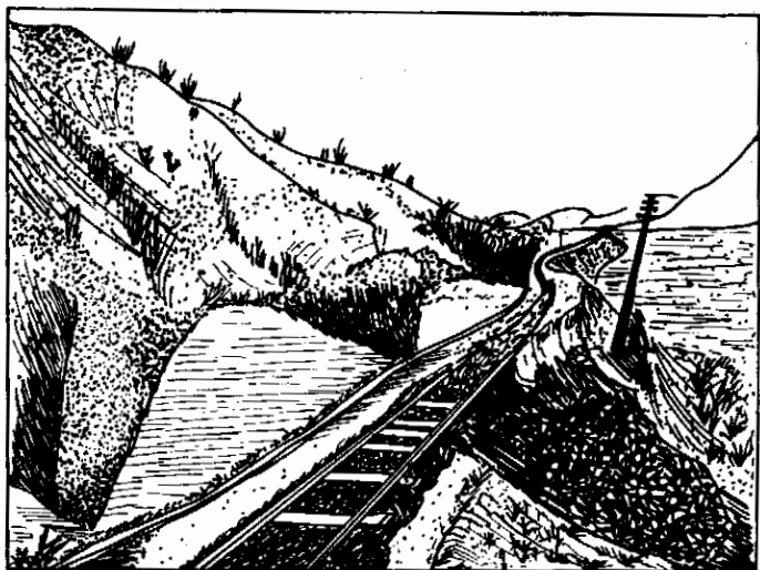
Hình 1.4. Trượt sườn (tuyến đường sắt Hà Lào)
