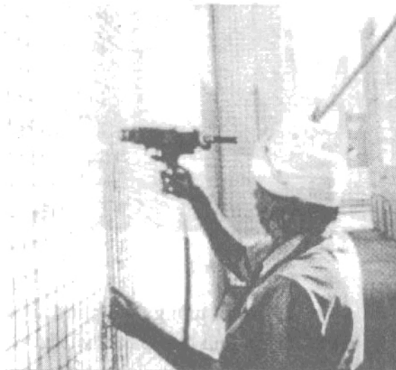
Hình 1.8. Nối panel bằng dụng cụ "horring gun"
