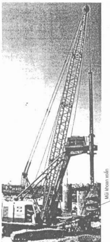
Hình 68: Khoan xoay có đầu khoan mũi xoắn
