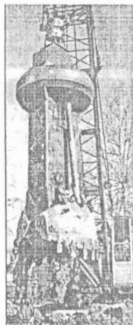
Hình 63: Gầu ngoạm đá vụn ở đáy lỗ khoan
