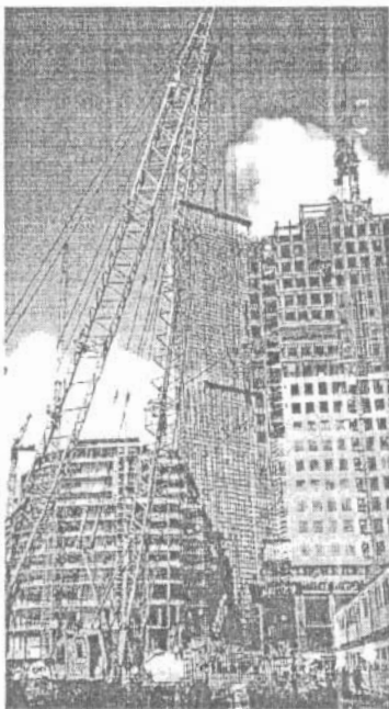
Hình 137: Lồng thép đã được treo thẳng đứng chuẩn bị hạ vào rãnh đào
