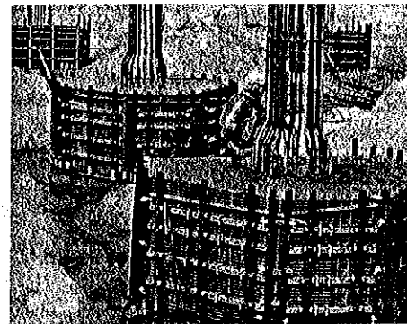
Hình 1.101. Ván khuôn móng cột bằng nhựa
