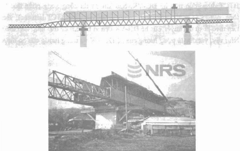
Hình 2.4: Giải pháp dây dưới đúc trên (underlung).
