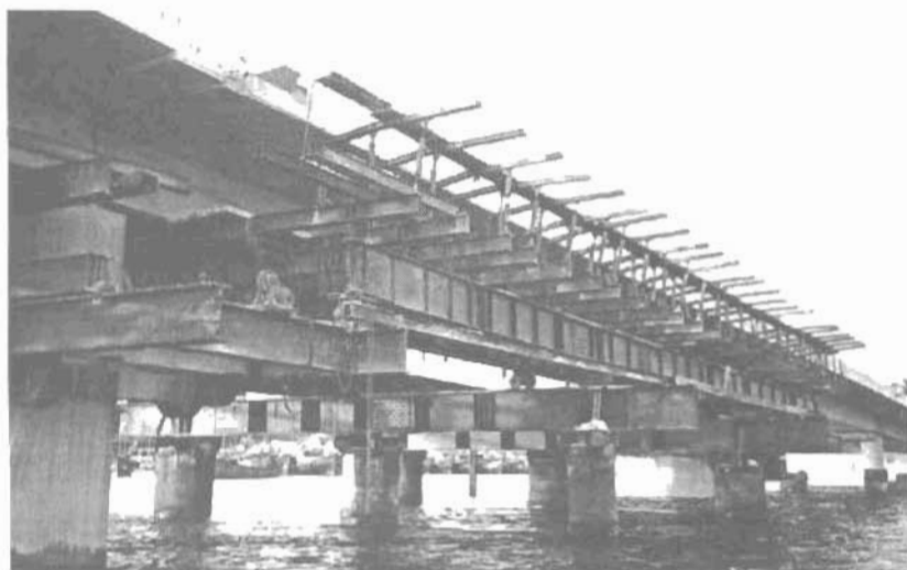
Hình 1.9: Thi công các nhịp dẫn cầu Nhật Lệ bằng công nghệ DCĐG (dạng trụ tạm đặt ở các vị trí trong phạm vi chiều dài nhịp)
