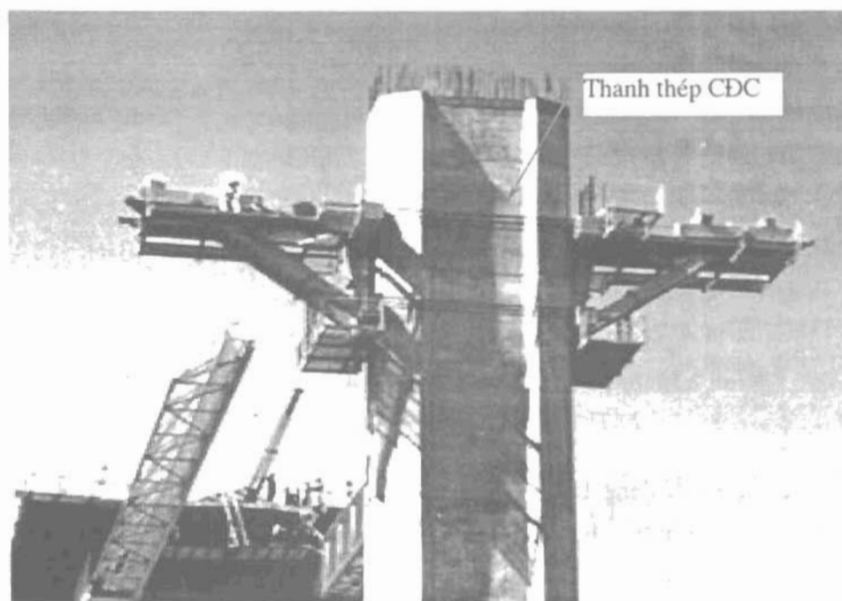
Hình 2.19: Giá đỡ thép được liên kết vào T.C.T bằng thanh thép cường độ cao (không sử dụng cột chống trên bộ móng)
