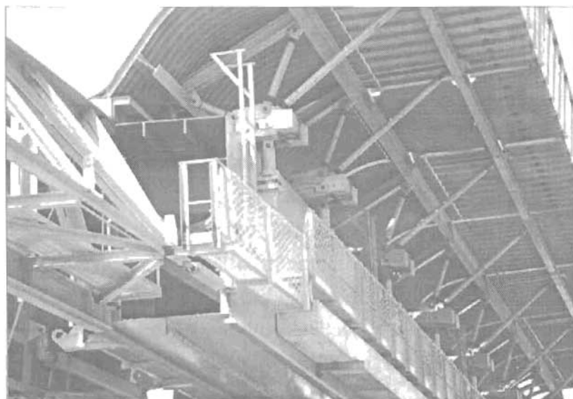
Hình 2.34: VK ngoài và hệ thống kích điều chỉnh nâng hạ chuyên dụng (Tăng đơ, thủy lực)
