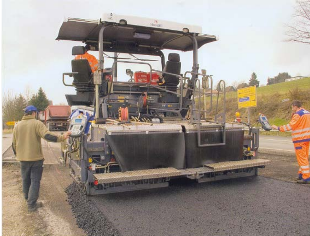
Hình 10.1. Máy rải bê tông asphalt
