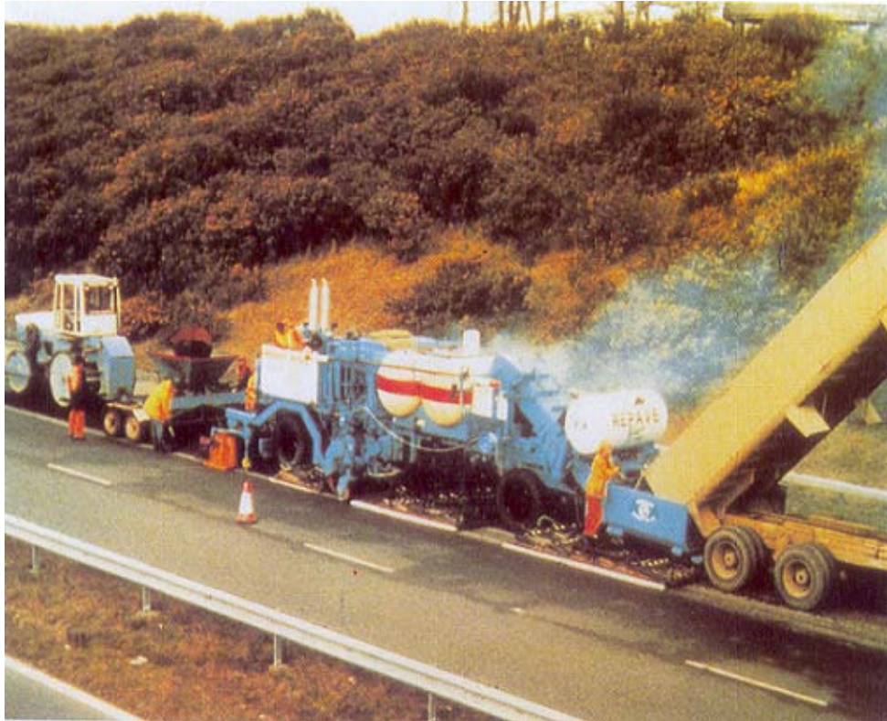
Hình 9.6. Quá trình rải lại mặt đường
