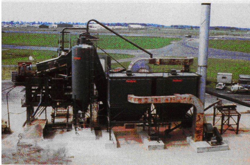
Hình 9.3. Trạm trộn được lắp đặt để phục vụ xây dựng sân bay
