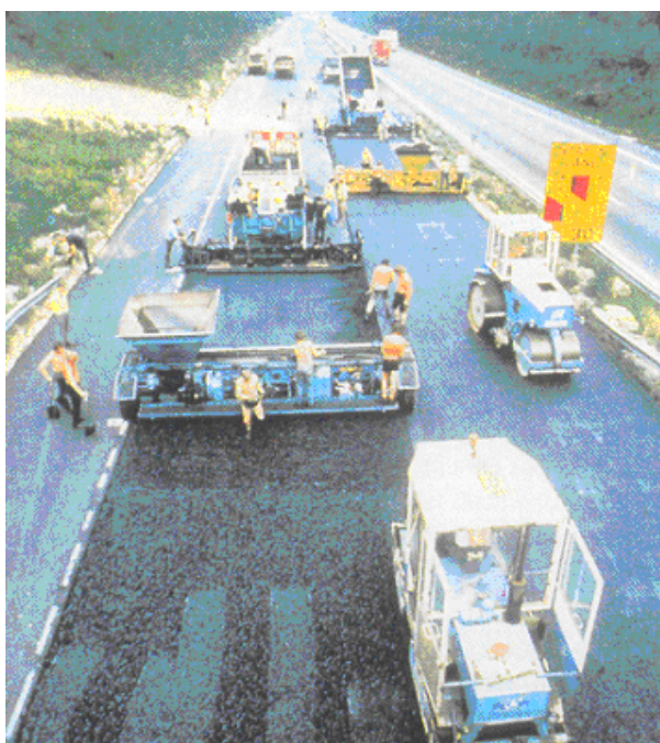
Hình 10.5. Toàn cảnh rải và đầm nén lớp mặt bằng asphalt rải nóng
