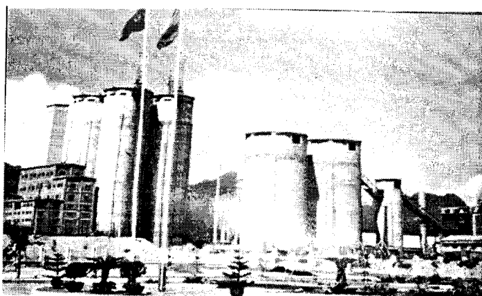
Hình 8: Hệ thống silô của Nhà máy xi măng Bút Sơn có kết cấu thành là bê tông ứng suất trước căng sau (1997)
