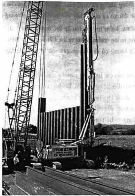
Hình 3-10: Thi công ép cọc cừ.
