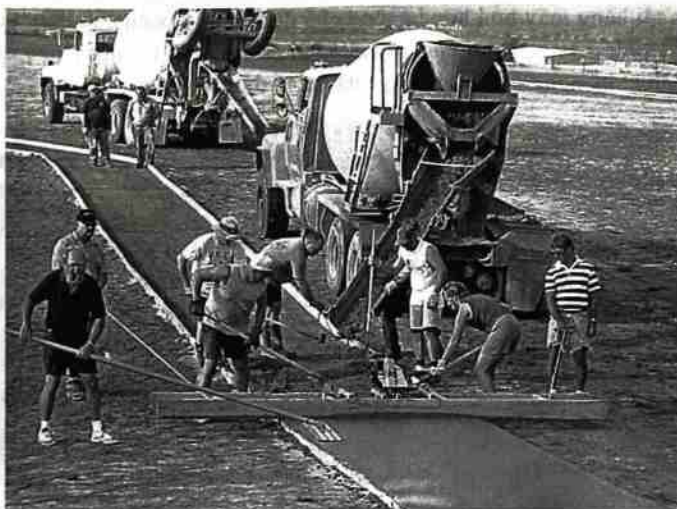
Hình 5-21: Trộn và đổ bê tông.
