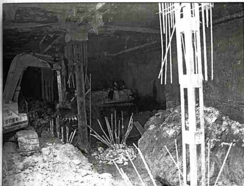
Hình 6-27: Máy xúc kết hợp máy ủi để gom đất.
