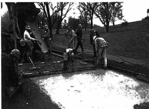
Hình 5-22: Đám bê tông (đám thước).
