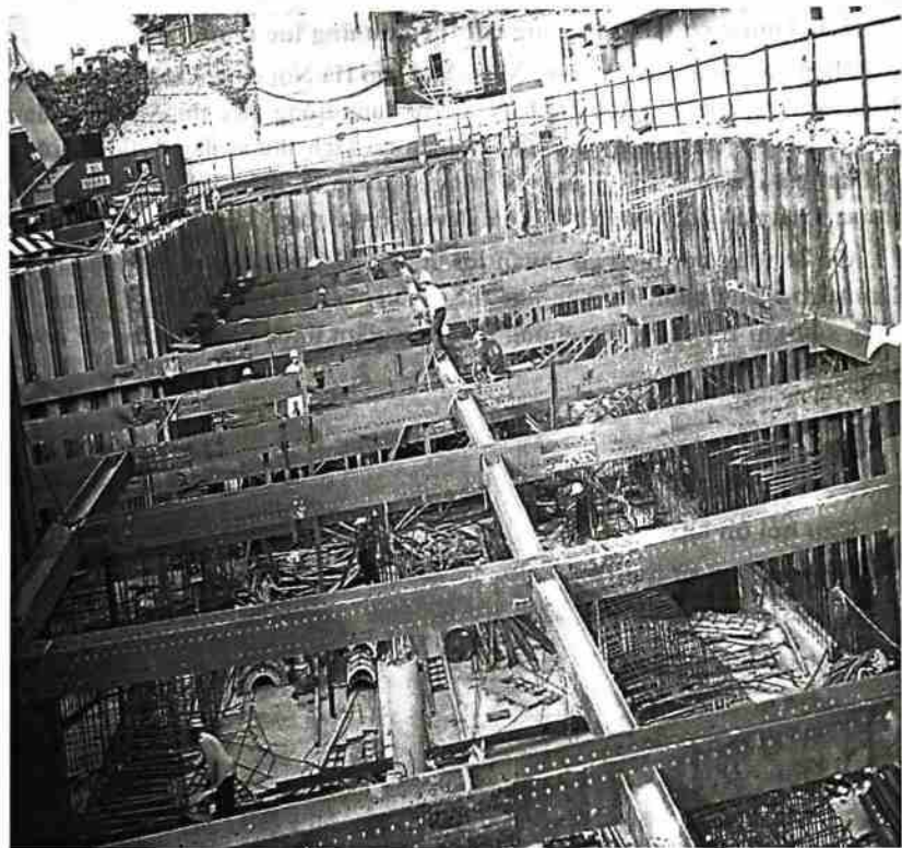
Hình 3-11: Hệ thống chống đỡ cừ.
