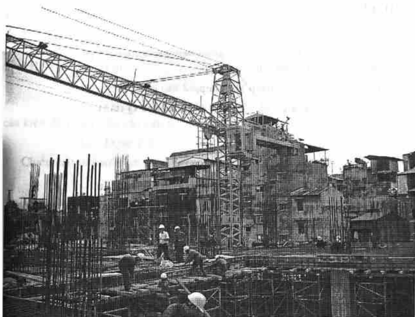
Hình 9-13: Cần trục leo dặt trong công trình.
