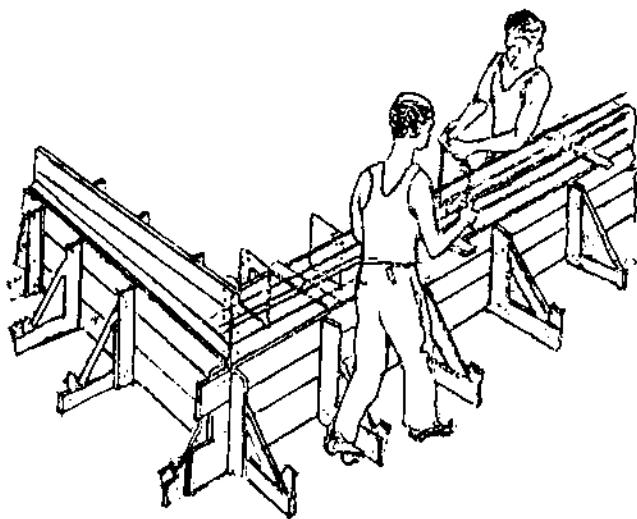
*Hình 3.32. Dựng buộc cốt thép dầm tại chỗ*
