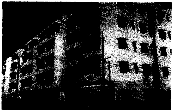
Chung cư Đình bộ Lĩnh 5 tầng Dùng móng băng trên cử tràm
