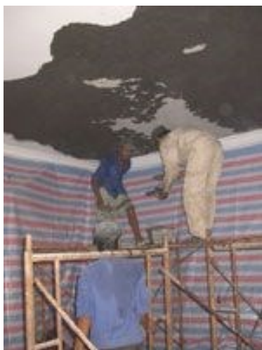
Công việc trát lại trần, sửa chữa hư hỏng được nhà thầu triển khai ngay trong sáng 11/9. Ảnh: T.Q
