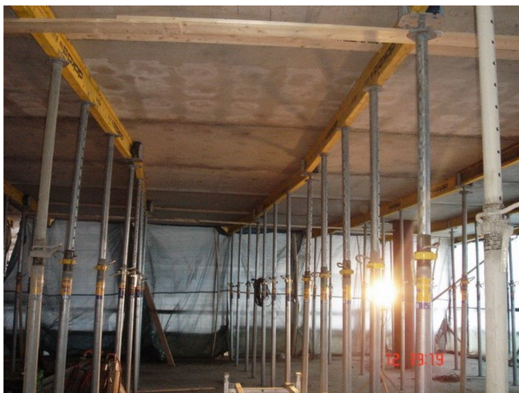
18. Hệ giáo chống nhìn từ bên dưới, các thanh đặt ngang tấm bê tông 6cm đã đổ trong nhà máy.
