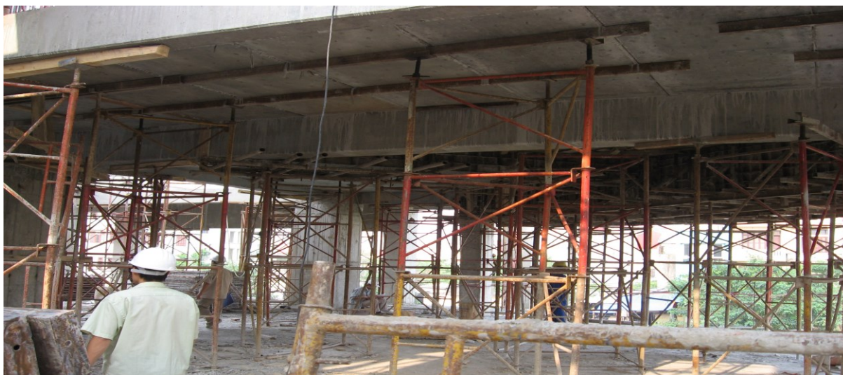
Hình 1.13: Thi công hệ giáo chống cho dầm và sàn tại công trường
