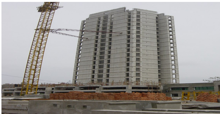
Hình 1.12: Thi công trượt lõi cứng kết hợp lắp ghép các tấm cột, dầm và sàn
