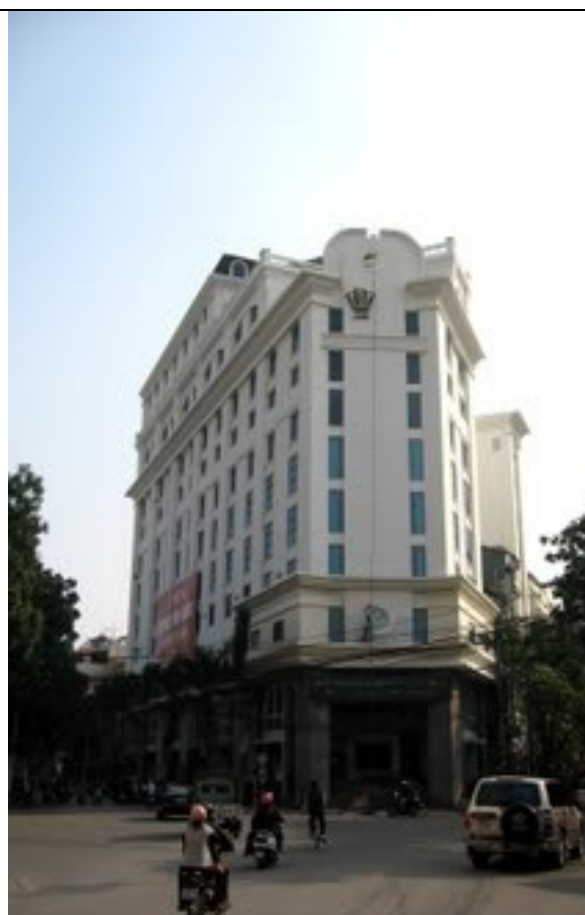
Toà nhà 193 Bà Triệu trước và sau khi nâng tầng sử dụng công nghệ Bubbledeck và không cần gia cố nền móng
