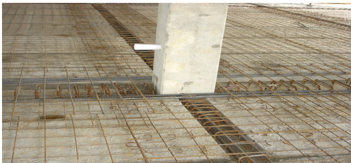
Hình 1.11: Mặt bằng thép sàn đổ bù
