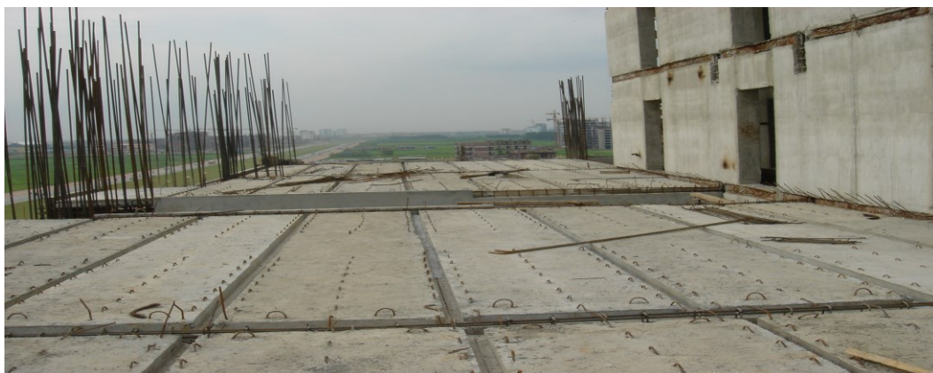
Hình 1.10: Lắp ghép panel sàn tại cụng trình Vimeco
