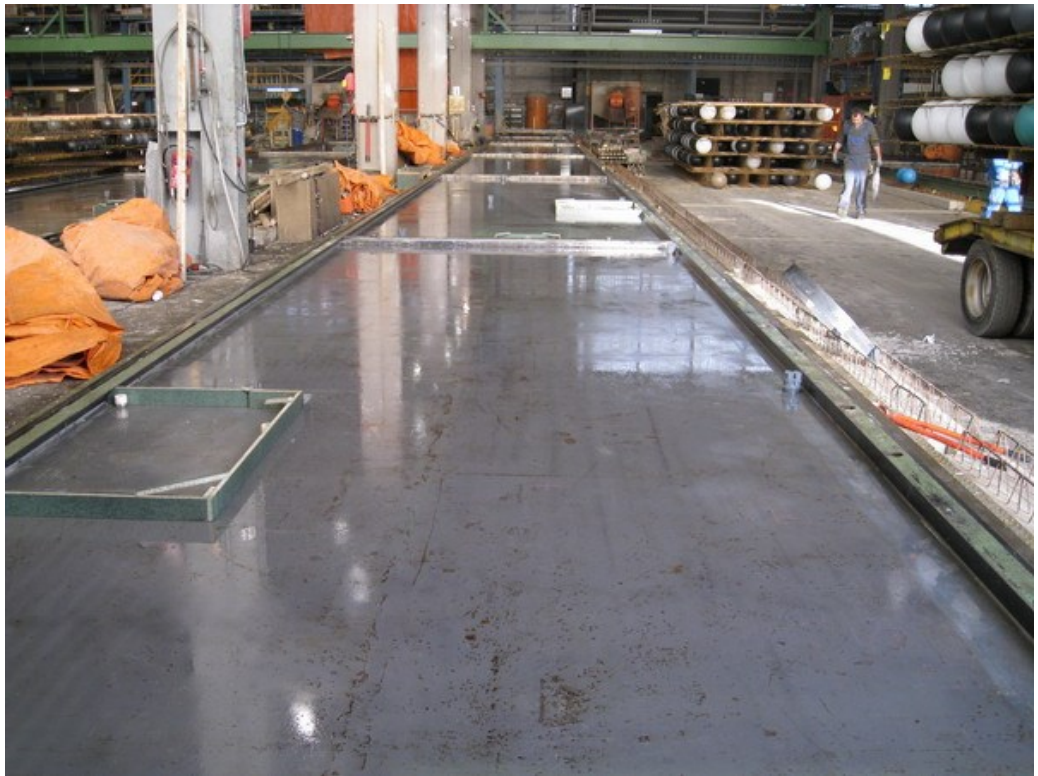
6. Chuẩn bị ván khuôn, thành ván khuôn cao khoảng 6-7cm, ván khuôn bằng thép nhấn được thổi dầu cặn dạng sương để chống dính
