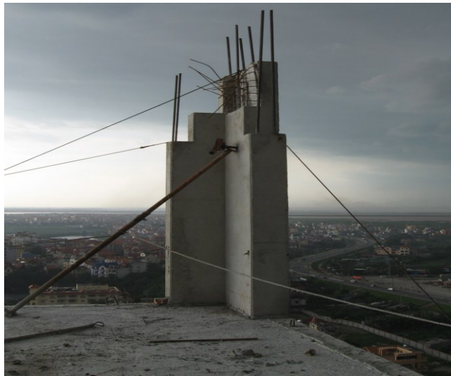
Hình 1.2: Chống đỡ cột tại công trình Syrena Hồ Tây
