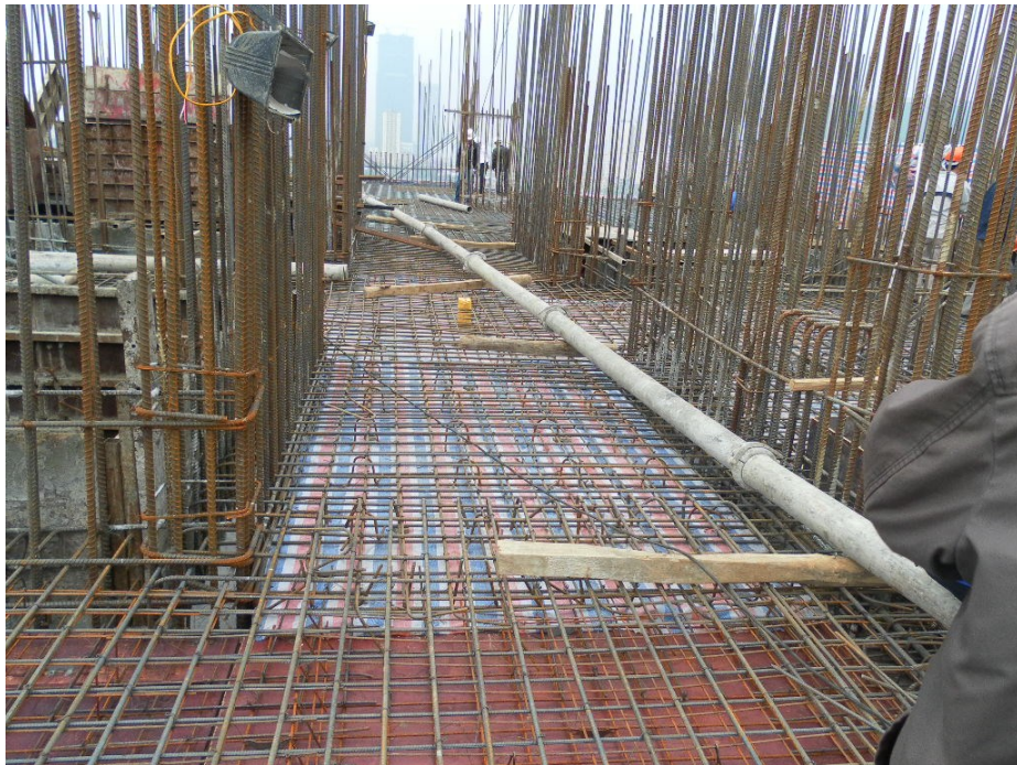
B5: Đổ bê tông kết hợp đầm
