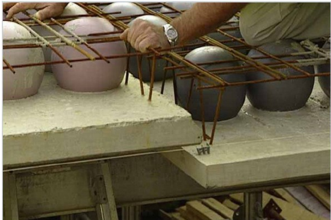
9. Bố trí các tấm trên mặt bằng phải theo sơ đồ thiết kế do lưới cốt thép phía dưới bố trí khác nhau trên sơ đồ sàn
