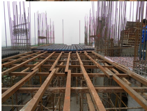
B2: Cầu lắp các phen gồm các tấm ván khuôn trên đó đã giải thép và đặt bóng sần tại xưởng
