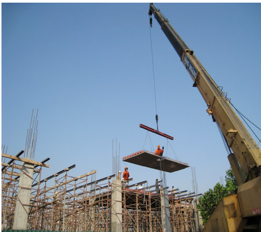
17. Cầu các tấm lên đặt lên hệ giáo, mỗi tấm 2.4x9m nặng khoảng 3.5 tấn
