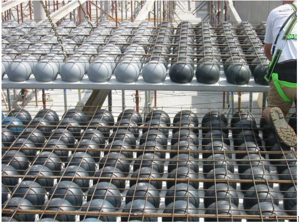
9. Bố trí các tấm trên mặt bằng phải theo sơ đồ thiết kế do lưới cốt thép phía dưới bố trí khác nhau trên sơ đồ sàn
