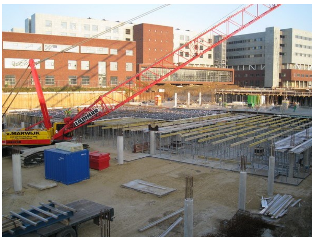
15. Công trình có bước cột 16.5m ( Bước cột tương đối lớn)
