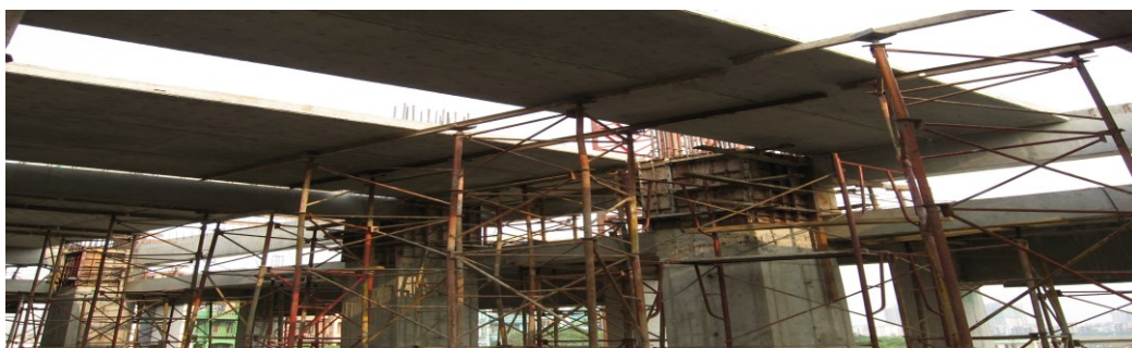
Hình 1.9: Thi công hệ chống đỡ panel sàn lắp ghép
