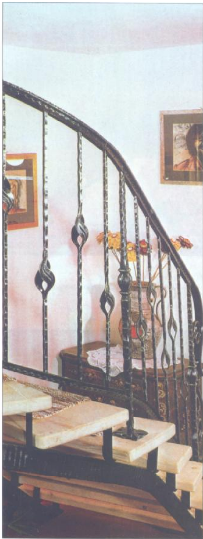
Hình bên trái: cầu thang với kiểu khung mở nâng đỡ hai công rất tuyệt, gắn với thành vịn bằng sắt rèn được thiết kế với những song sắt và tay vịn có hoa văn trang trí.
