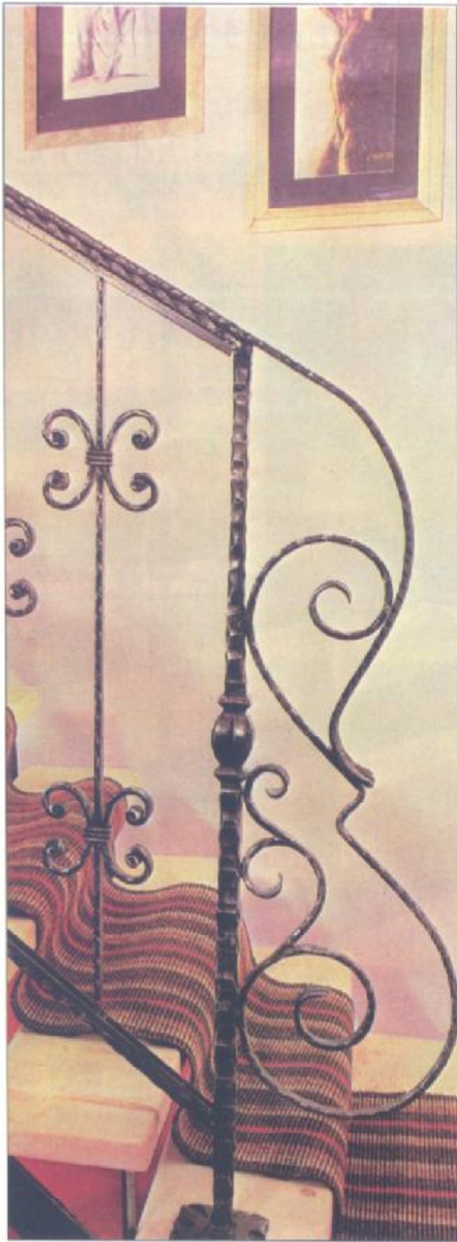
Hình phóng to cho thấy khớp nối giữa thành tay vịn và đường xoắn cong lớn trang trí cho cột trụ của thành vịn cầu thang. Ví dụ thứ hai với họa tiết kiểu Baróc có những vòng tròn lớn vào đã tạo ra những điểm lối duyên dáng cho cột trụ. Cả hai mẫu đều sơn màu đen và bạc cũ.
