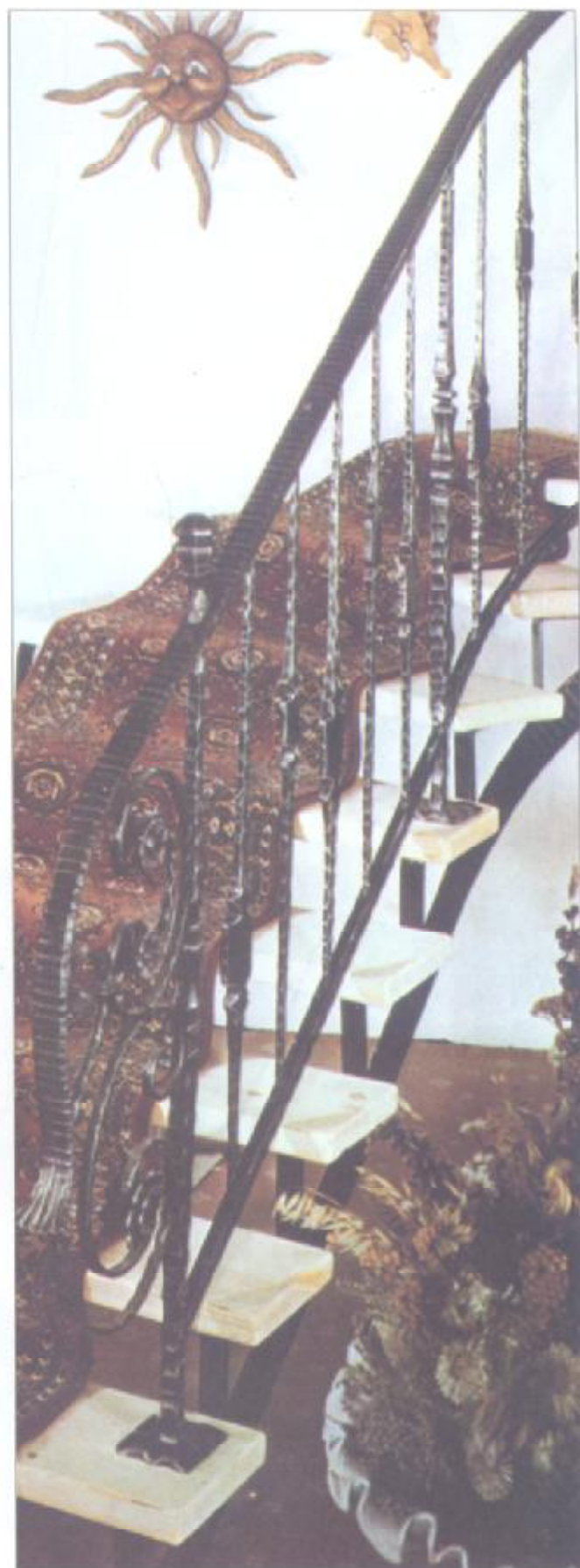
Kiểu thiết kế giản dị của các song sắt với những hình đĩa lờm dờm ở giữa mỗi song càng được tôn lên với những chiếc lá cách điệu ở đầu tay vịn. Màu bạc. Hình bên phải: một kiểu khác có song sắt được trang trí bằng hình chẻ nhọt to bản hơn và những đường cong với những hình hoa nằm giữa đầu tay vịn và thanh cột trụ.
