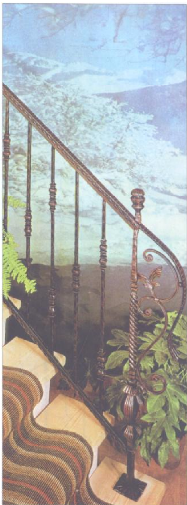
Hình bên trái: cầu thang với kiểu khung mở nâng đỡ hai công rất tuyệt, gắn với thành vịn bằng sắt rèn được thiết kế với những song sắt và tay vịn có hoa văn trang trí.
