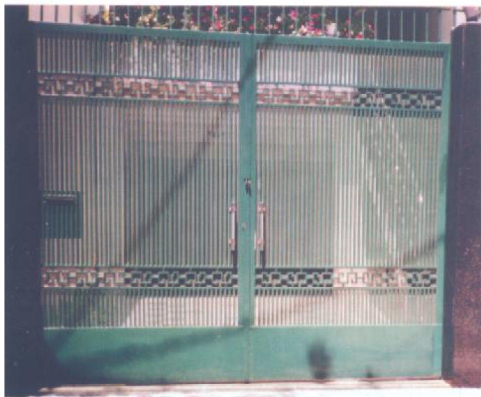
Hình trên: cổng sắt hai cánh với các thanh sắt thẳng đứng song song, phía trên và dưới được xen kẽ bằng những dây mắt xích cách điệu hình chữ S.
